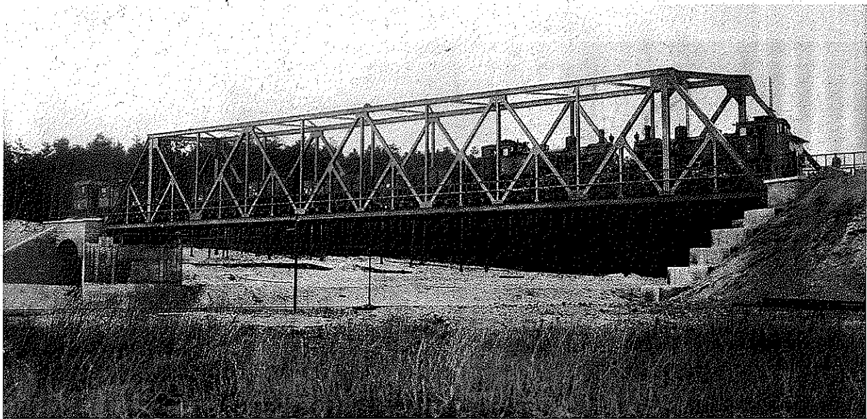
Brücke über den Teltow-Kanal, Probelauf mit 3 Lokomotiven im Jahre 1913
